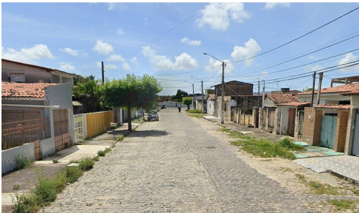
FOTO 2- RUA FRANCISCO WILSON
