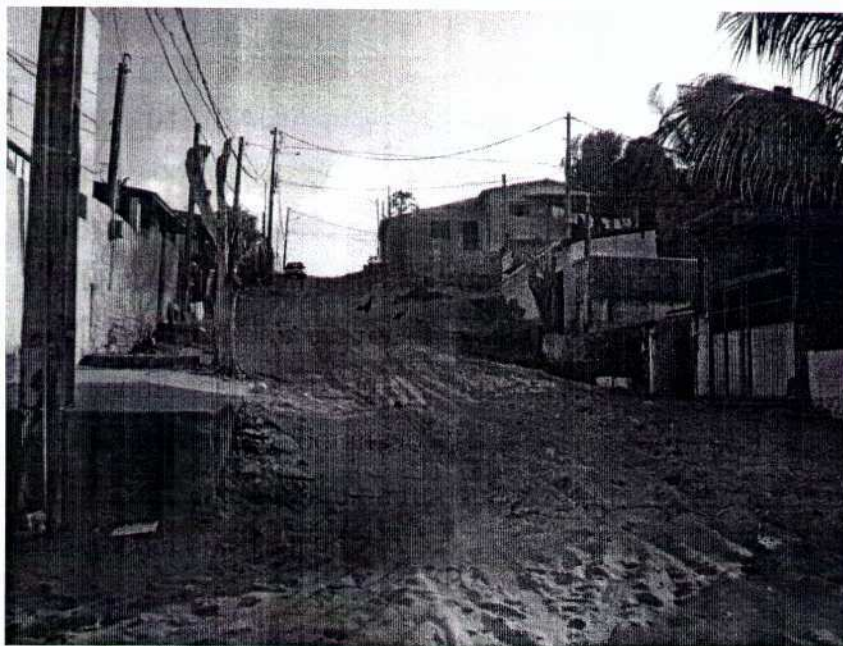
Figura 02 – Foto da Rua Paulo Roberto Pinto sem urbanização – declividade acentuada e dificuldade de tráfego de veículos e pedestres.
