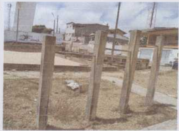
Foto 3- Reconstrução da academia;
