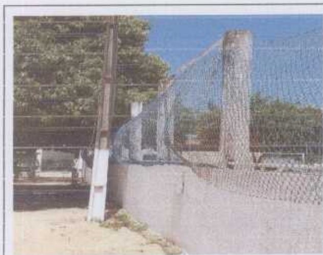
Foto 1 - Reconstrução de telas de proteção juntamente com a estrutura em aço galvanizado;
