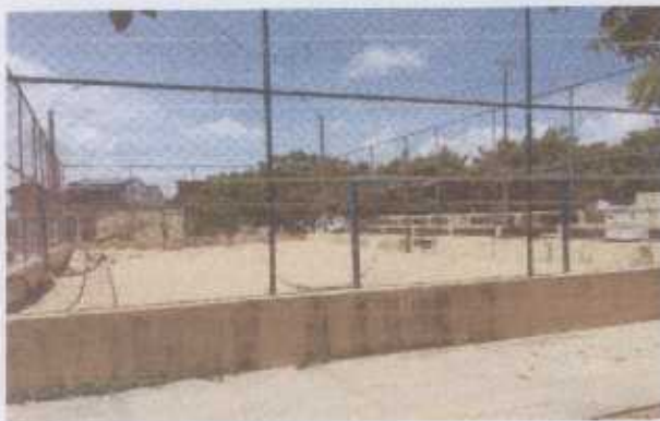
Foto 1- Recolocação de telas em alambrado e manutenção na estrutura de apoio em 40%
