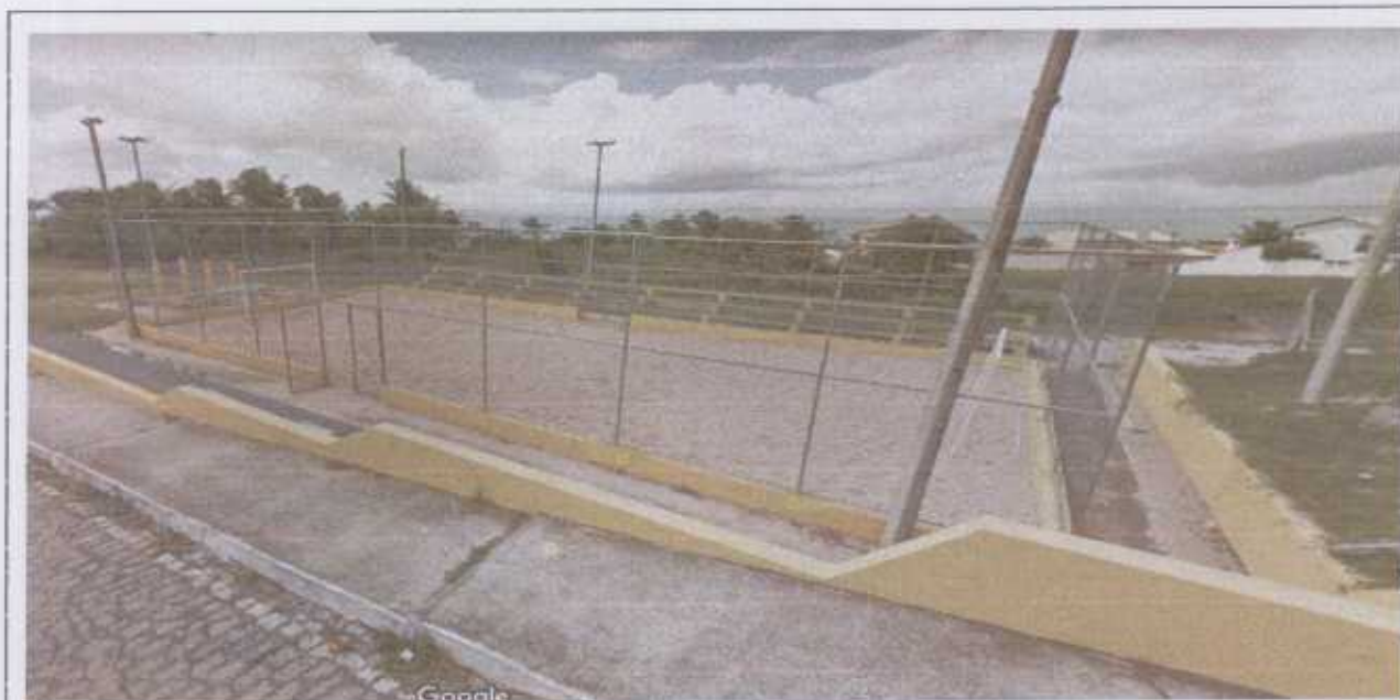
Foto 1 - Reconstrução de telas de proteção juntamente com a estrutura em aço galvanizado;
