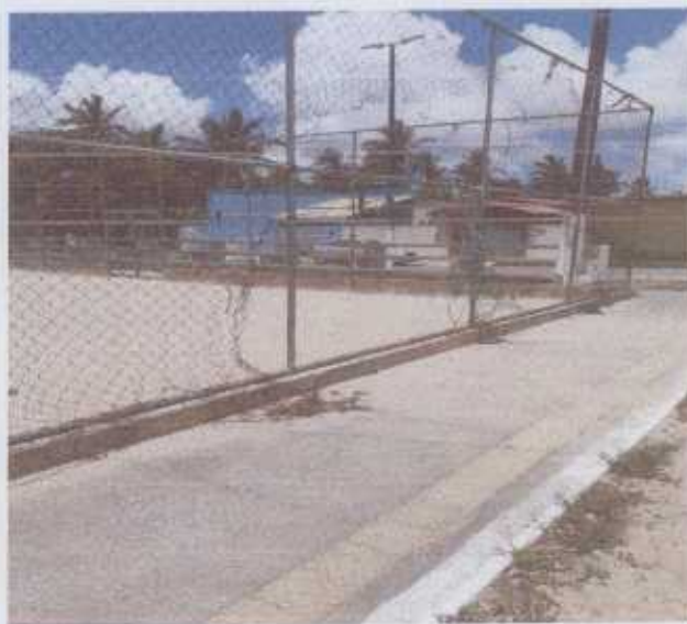
Foto 2 – Reposição das telas de proteção em alambrado e Pintura geral
