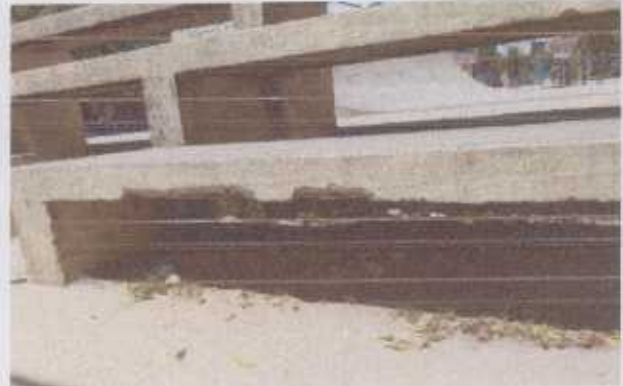
Foto 2- Manutenção na arquibancada em 10 m 2 de reboco.
