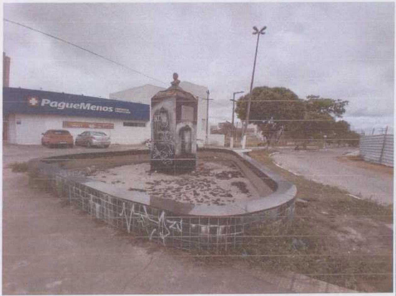
Foto 1- Reforma da fonte;
