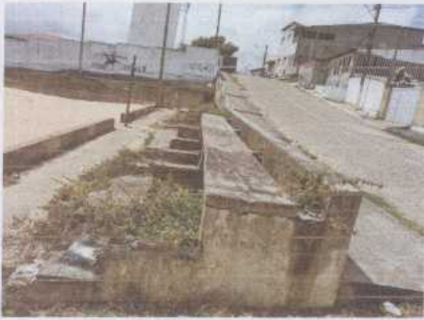
Foto 2 - Reconstrução das arribancadas;
