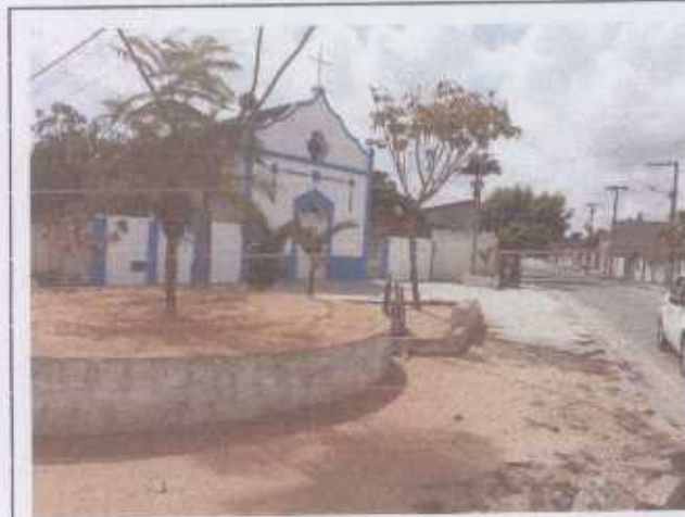
Foto 1 – Pintura geral e Manutenção no piso;
