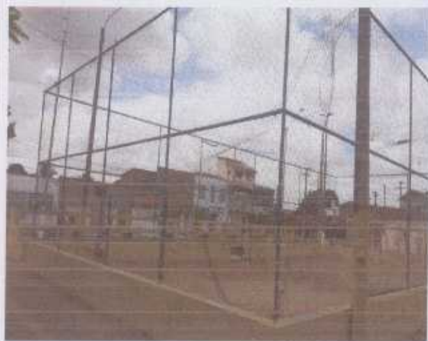
Foto 01: Recolocação das telas de alambrado;
