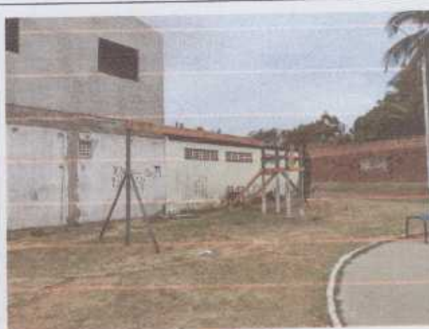
Foto 2 – Reconstrução do parquinho infantil com 40 horas de 1 marceneiro com 1 auxiliar;
