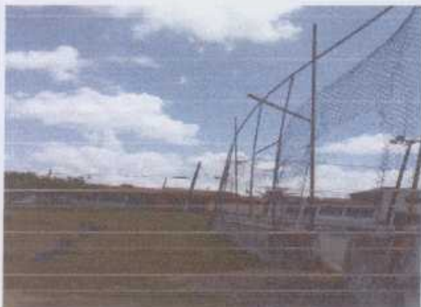
Foto 1 - Reconstrução de telas de proteção juntamente com a estrutura em aço galvanizado;
