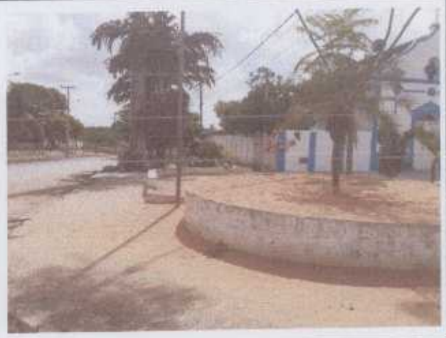
Foto 2 – Pintura geral e Manutenção no piso;
