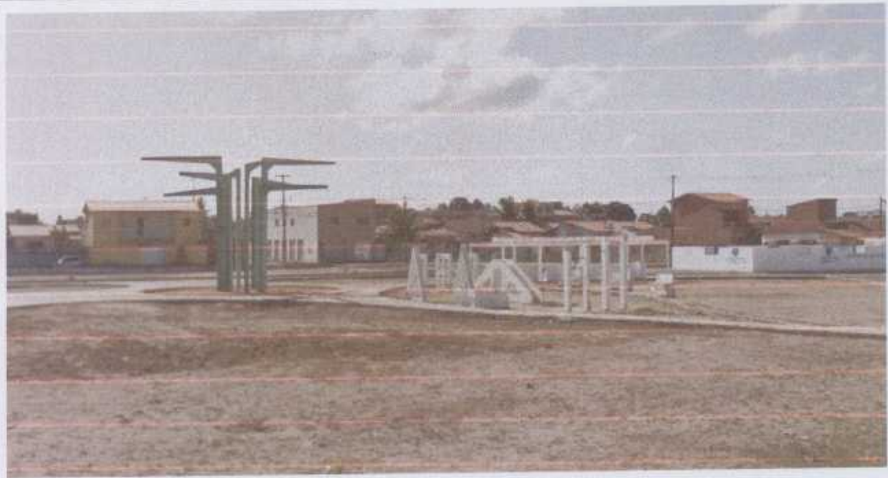
Foto 2 - Manutenção e, limpeza e pintura geral;
