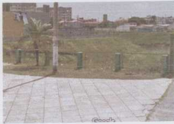
Foto 2 – Pintura e manutenção na varanda de proteção da lagoa;
