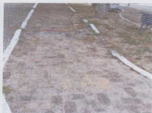
Foto 2 – Manutenção do piso intertravado;
