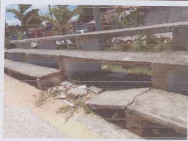
Foto 2- Manutenção na arquibancada;
