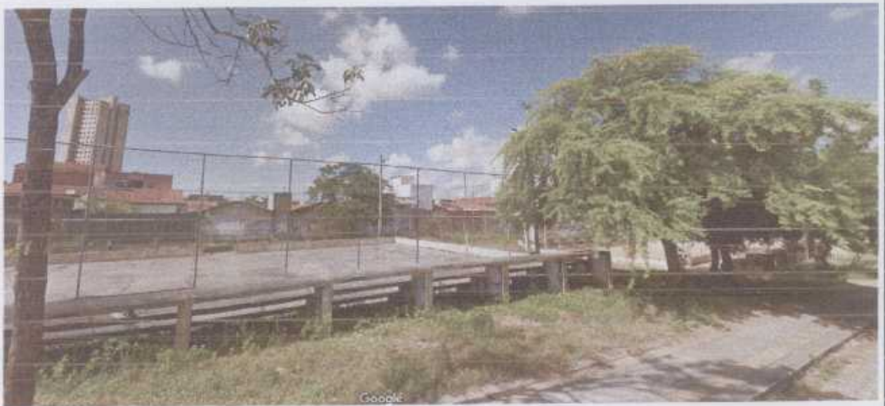
Foto 2 - Limpeza geral e Pintura;
