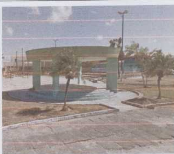
Fotos: pintura geral;
