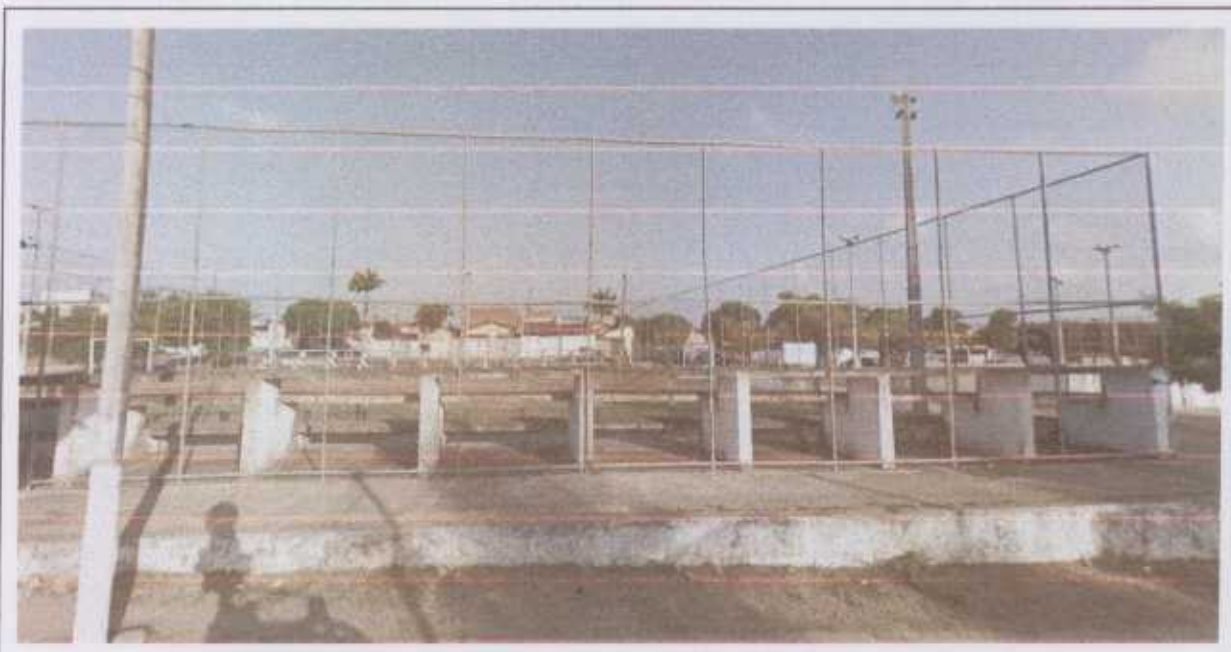
Foto 1 - Pintura e limpeza geral da área;
