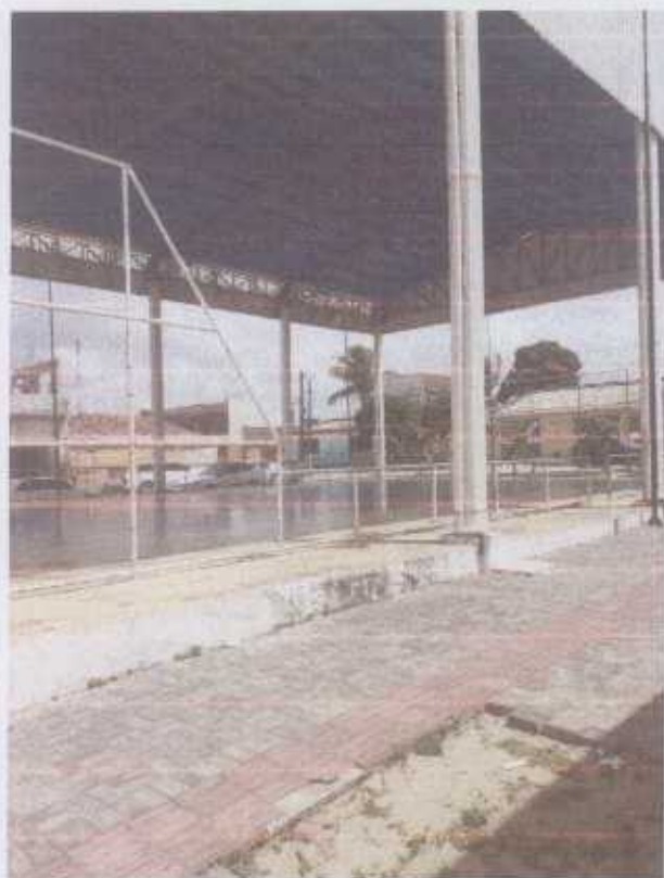
Foto 01- Recolocação de alambrado;
