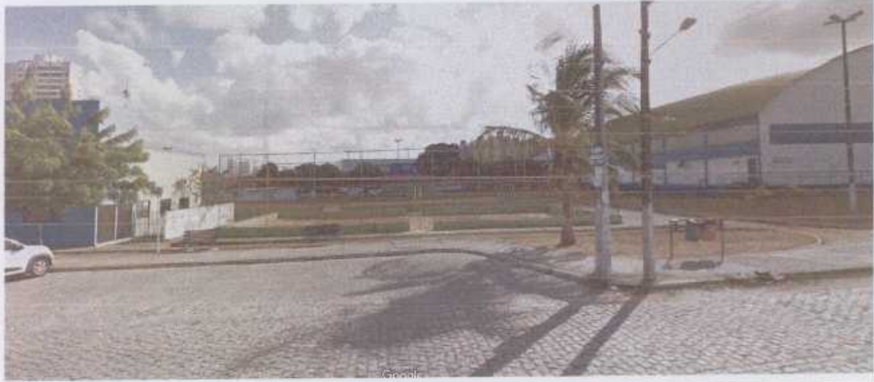
Foto 1 - Limpeza e Pintura geral
