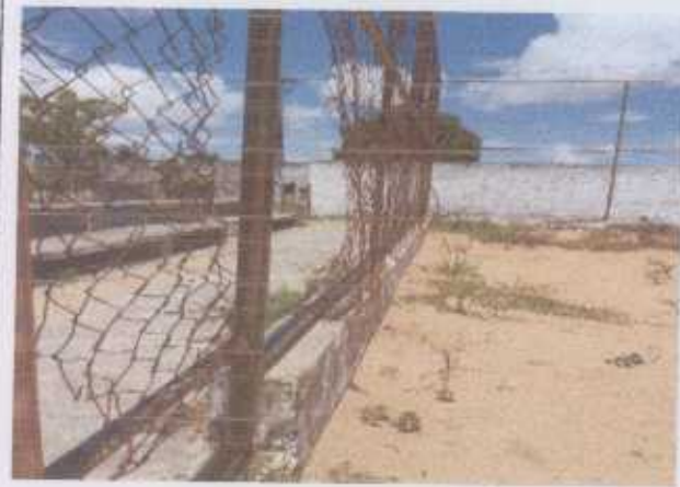
Foto 1- Recolocação de telas em alambrado e manutenção na estrutura de apoio;
