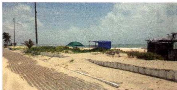
Figura 3. Mureta e vegetação fazendo a contenção da duna. Fonte: Glênio Lima, 2017.
